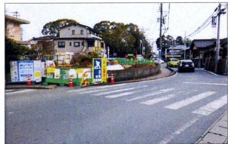
▲工事中の笛神社前交差点
