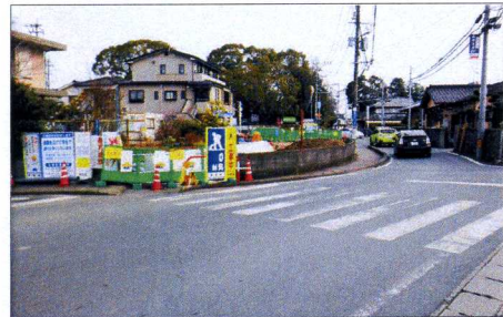
▲工事中の笛神社前交差点
