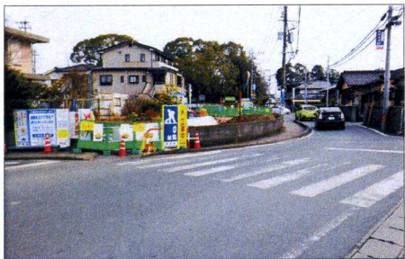
▲工事中の笹田神社前交差点
