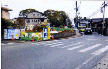
▲工事中の笹田神社前交差点
